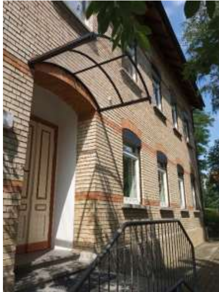
8. kép. A taldorfi iskola épülete
